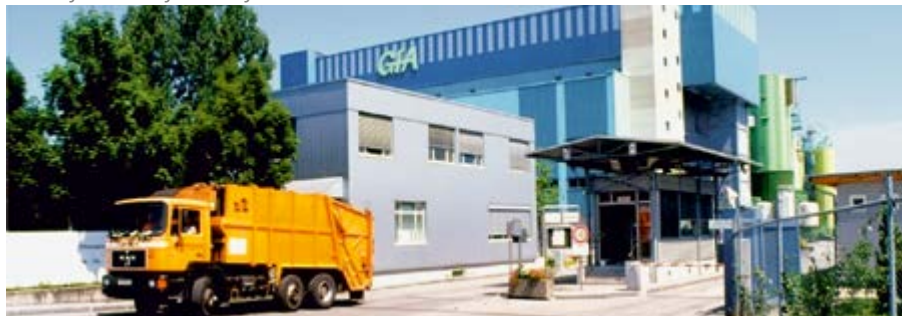
Das Abfallheizkraftwerk GfA in Geiselbullach
