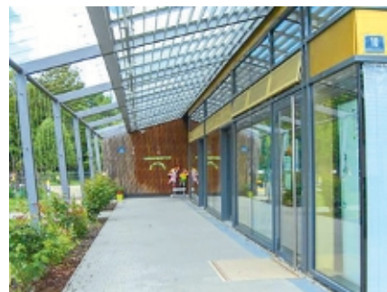
Kath. Pfarrsaal St. Jakobus (rechts), Kath. Kindergarten St. Jakobus (hinten), Gröbmaierstraße 10 (Foto privat 2020)
