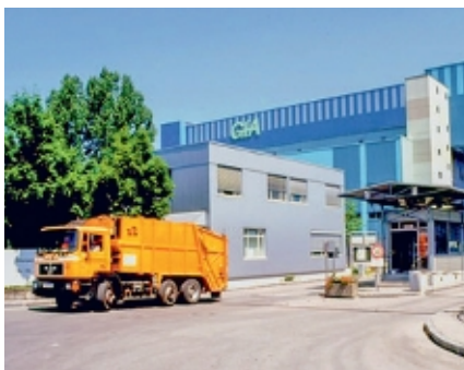
Das Abfallheizkraftwerk GfA in Geiselbullach
